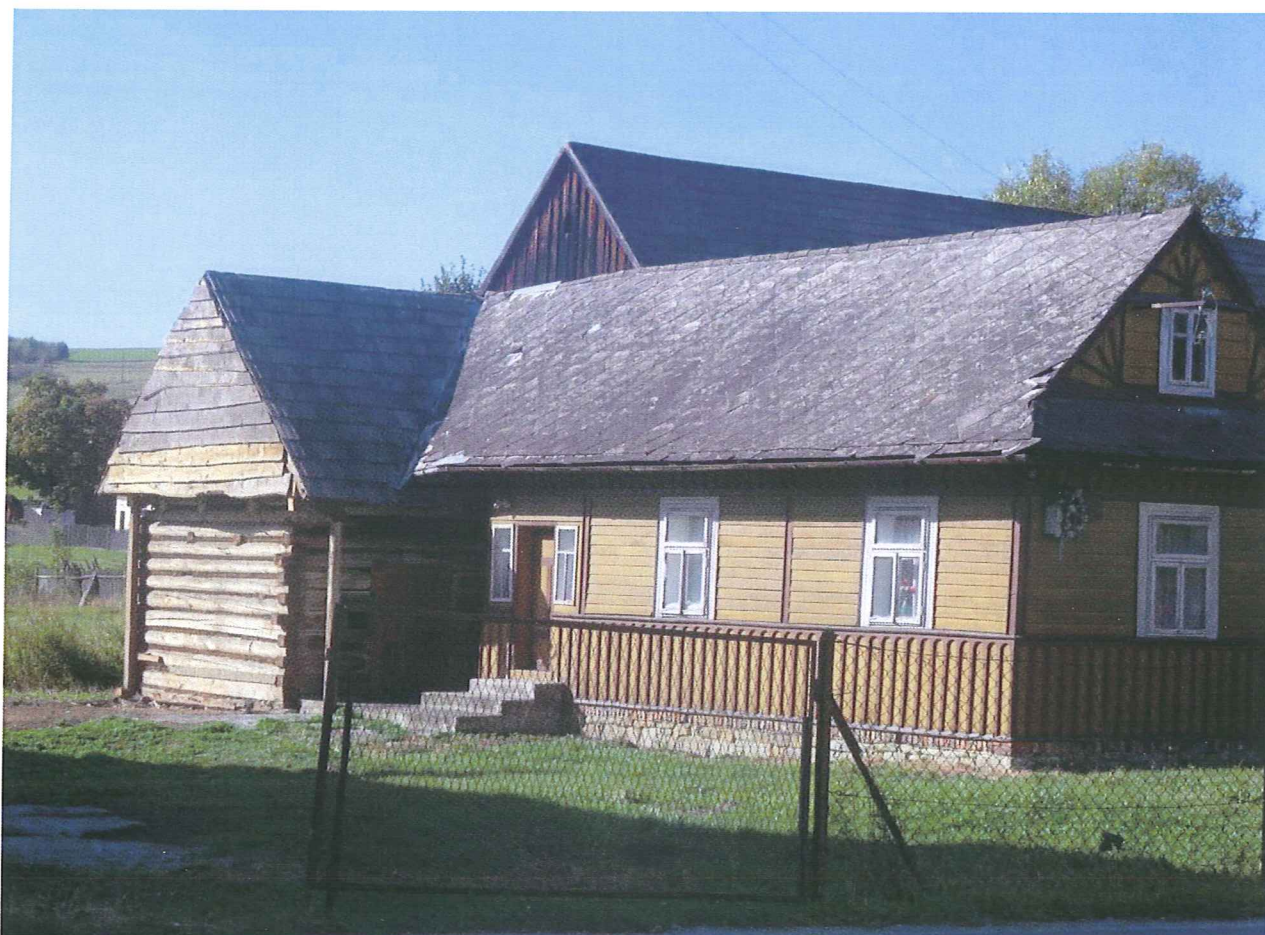
Pokrycie dachu budynku mieszkalnego eternitem płaskim.
