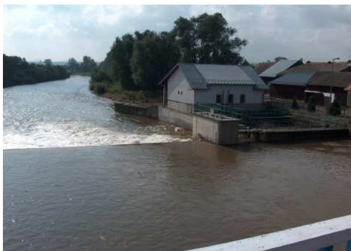
Rysunek 28. Widok na elektrownię wodną w gminie Nowy Targ w miejscowości Waksmund
